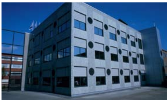
Automatisch gestuurde gevelopeningen Infrax-gebouw
