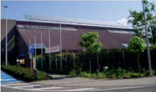
Zonneboilersysteem zwembad Beveren
